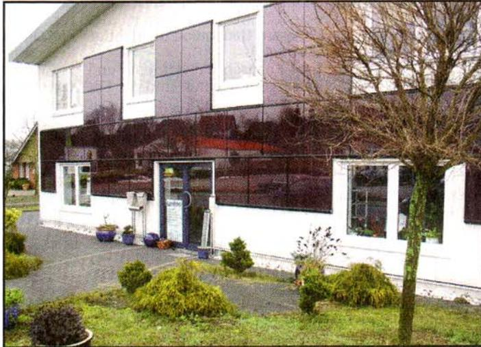
**Auch die Frontfassade von Laudeley Betriebstechnik wird nun für eine Photovoltaikanlage genutzt, die nach den neuen Richtlinien des EEG 2009 „Strom zur solaren Selbstnutzung“ betrieben wird.**
