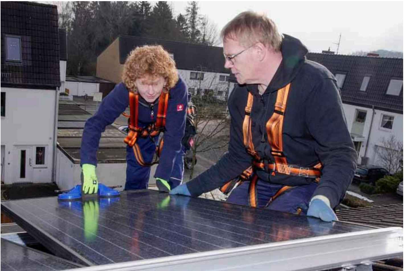
Cornelia Laudeley und Mitarbeiter Michael Strubenhoff bei der Dachmontage der Paneele.
